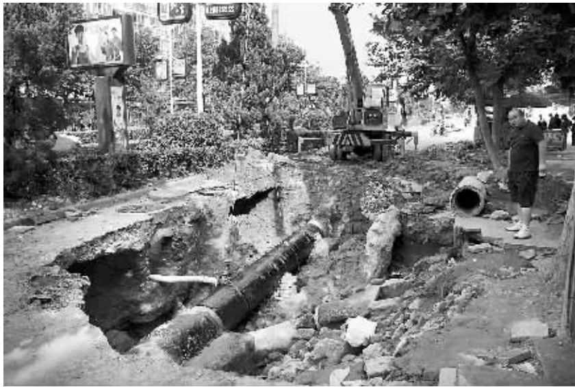
紧张施工,修复供水管道。晚报记者 鲁超 摄
