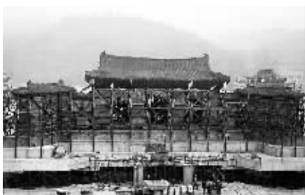
图为武当山遇真宫大山门和2个宫门顶升到15米高度。 中新社发
