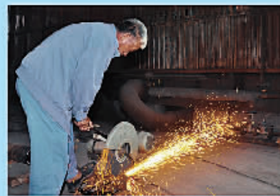
10吨锅炉检修改造现场
