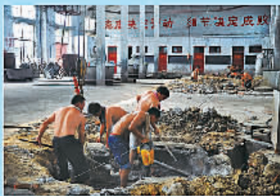
40摄氏度高温的车间内,改造酿酒设备
