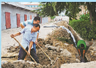
技术人员在进行供水管网改造
