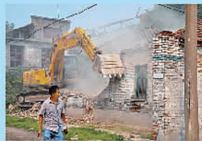
生产厂房扩建改造作业
