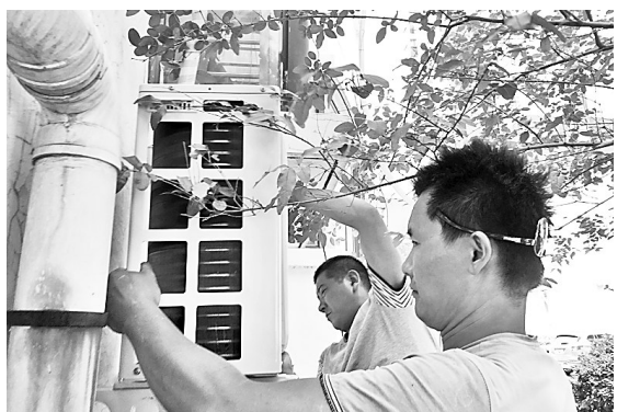
高温下安装室外机
