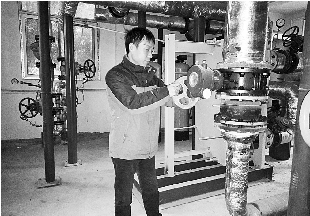
昨日,恒源热力的工作人员在建业·联盟新城小区内的热交换站进行试水试压
