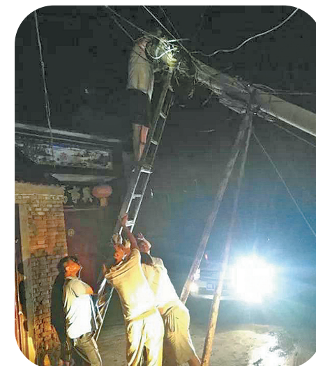
睢县分公司党员先锋队借助车灯夜间抢修忙
