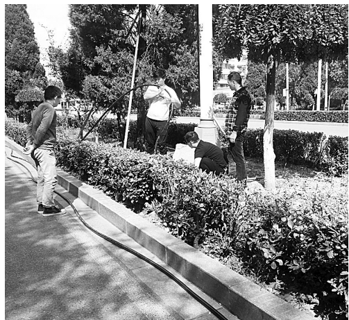
换路灯的电缆线。
