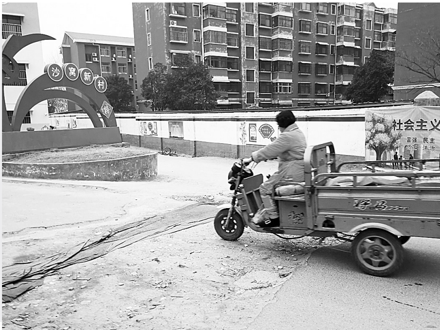
沙窝新村附近道路上的沟槽
