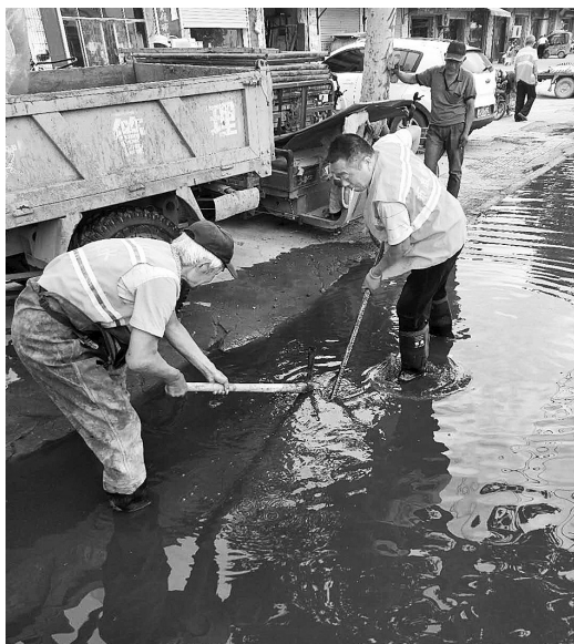
维修人员正在清理下水道
