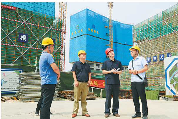
采访建业总部港项目工程建设情况
