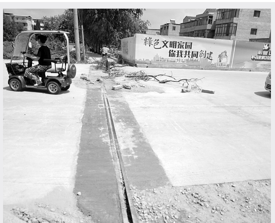
凹槽已用混凝土填平
