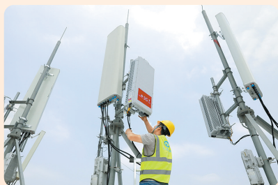
商丘联通加快5G基站及光缆施工进度
