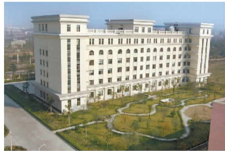
龙宇化工办公大楼
