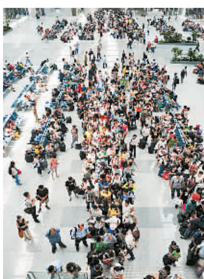
沈阳北站高架铁路候车大厅投入使用 7月15日，乘客在新建的候车大厅排队准备乘车。沈阳北站站房、高架候车大厅北广场投入使用，为旅客提供更开阔、舒适的空间和更便捷的服务。即日起，沈阳北站南侧广场将陆续封闭继续进行改建。 新华社发
