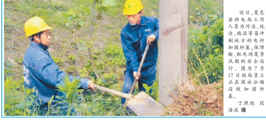
近日，夏邑县供电局工作人员为河洼、坑边、路沿等易冲刷地方的电杆加固杆基，保障电网夏季汛期的安全运行。图为7月17日该局员工正在商永公路沿线加固杆基。
