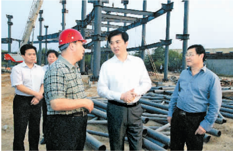
10月7日,市委书记陶明伦在商务中心区展示中心项目施工现场,详细了解工程进展情况。本报记者 马基随 摄
