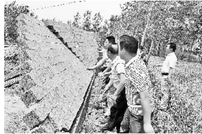
6月12日,夏邑县国土资源局执法监察大队对李集镇郭庄村小张庄一处非法占用耕地建设的液化气站进行拆除,此次行动确保了土地红线,起到了拆除一处、教育四方的良好效果。本报记者 韩丰 通讯员 张瑞波 摄
