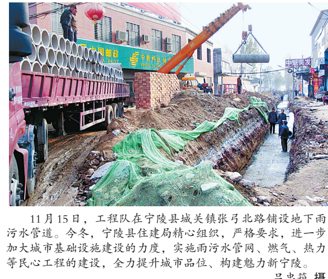
11月15日,工程队在宁陵县城关镇张弓北路铺设地下雨污水管道。今冬,宁陵县住建局精心组织,严格要求,进一步加大城市基础设施建设的力度,实施雨污水管网、燃气、热力等民心工程的建设,全力提升城市品位、构建魅力新宁陵。 吕忠箱 摄
