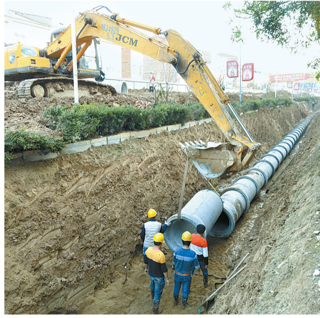
11月16日,记者看到,睢阳区毛堌堆镇“美丽乡村”项目正在建设实施。该项目共投资1315万元,工期约45天。项目建设内容为镇区内道路工程、雨污水管道工程、绿化工程、照明工程等,涉及镇区内南栢路、和谐路、民主路、利民路四条道路。项目完工后,毛堌堆镇将进一步加大城镇管理力度,完善市场化运营机制,努力打造全国重点镇名片,打造“天蓝、街美、水清”的宜居环境。 本报记者 白鹏 摄
