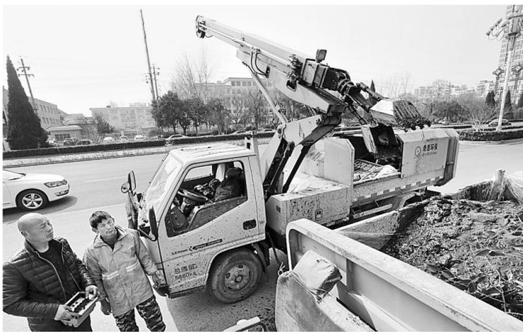
3月16日,工作人员正在疏通下水道。连日来,市城市管理局排水管网管理处工作人员积极行动,对辖区内的地下管道和雨水井进行了疏通、清淘,以确保雨季排水顺畅。
