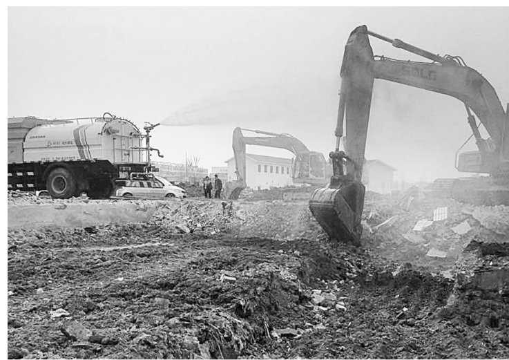
3月30日,挖掘机正在商都公园工地湿法作业。本报记者 李娅飞 摄
