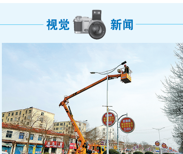
4月11日,夏邑县电力施工队员在检修路灯。该县把路灯管理纳入民生工程来抓,对不亮的路灯及时更换,为夜间出行的居民提供方便。本报记者 韩丰 摄
