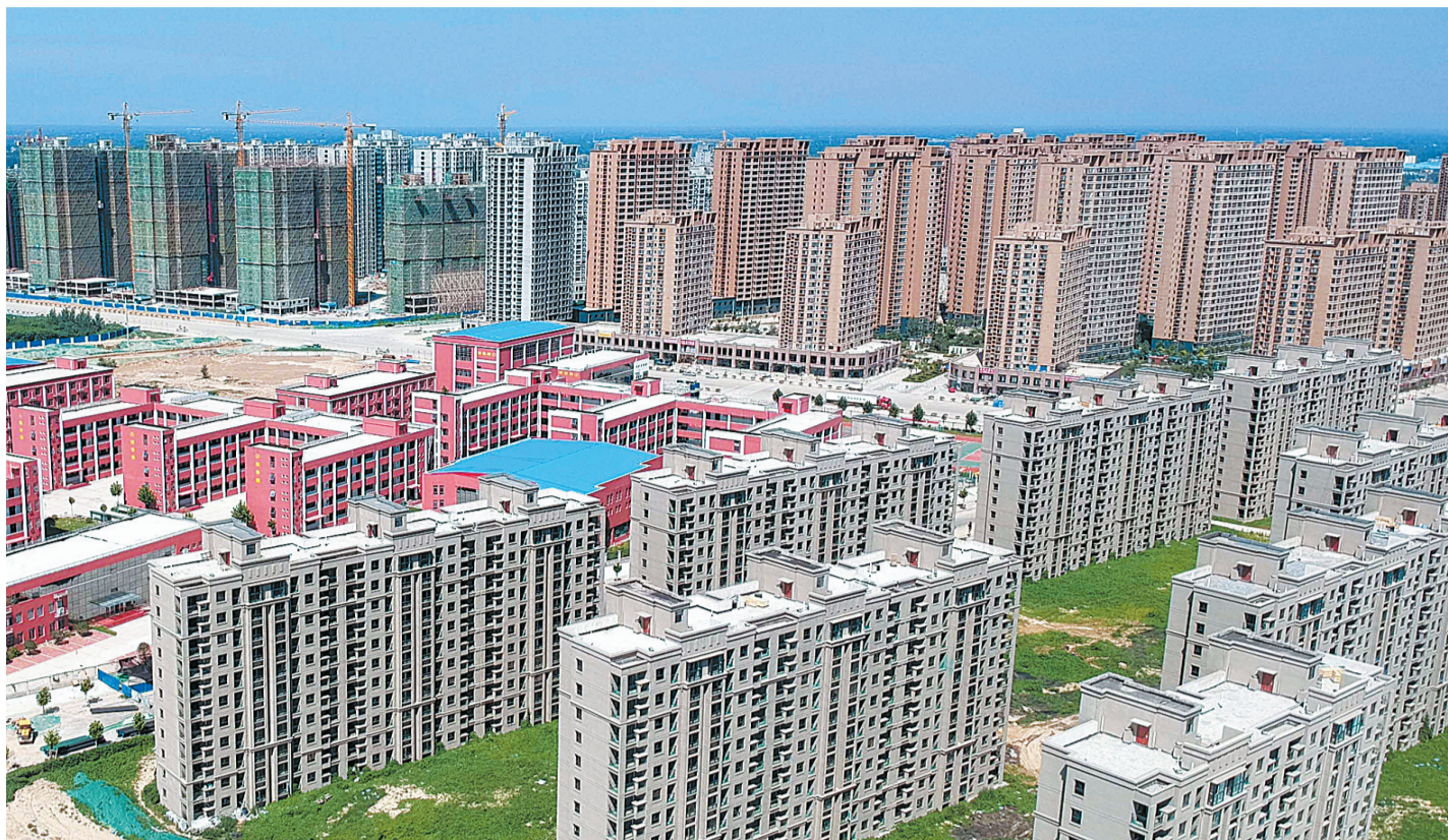
高铁新城安置区建设如火如荼。本报记者 单保良 摄
