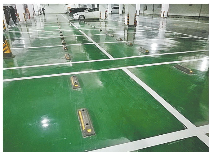
改造后的建业·桂园地下车库。
