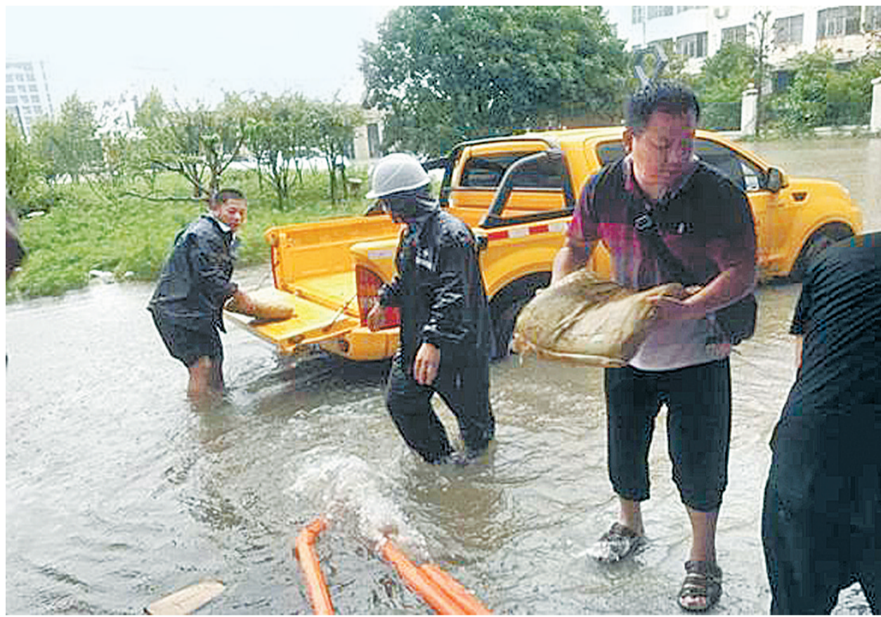
内排水外扛沙袋筑防线
