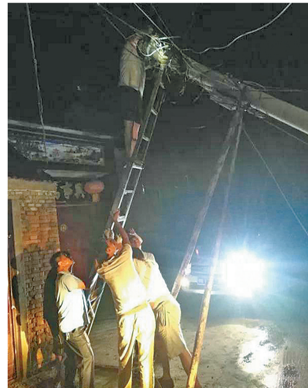
睢县分公司党员先锋队借助车灯夜间抢修忙
