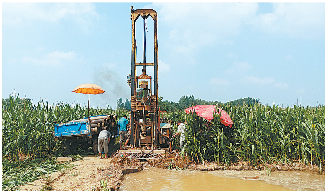
梁园区水池铺乡吴楼村是该区财政局精准扶贫帮扶村,自对该村帮扶以来,该局驻村工作队通过深入摸底和走访座谈,发现该村农田灌溉用水不足、基础设施薄弱,且原有井多已干涸,不能满足该村村民灌溉用水需求。为此,该局驻村工作队积极协调,申请省级财政资金262.1万元,为该村新打机井44眼,铺设埋地管、地理线22.4公里,安装变压器4台。目前,该项目已开工建设。李杰 摄
