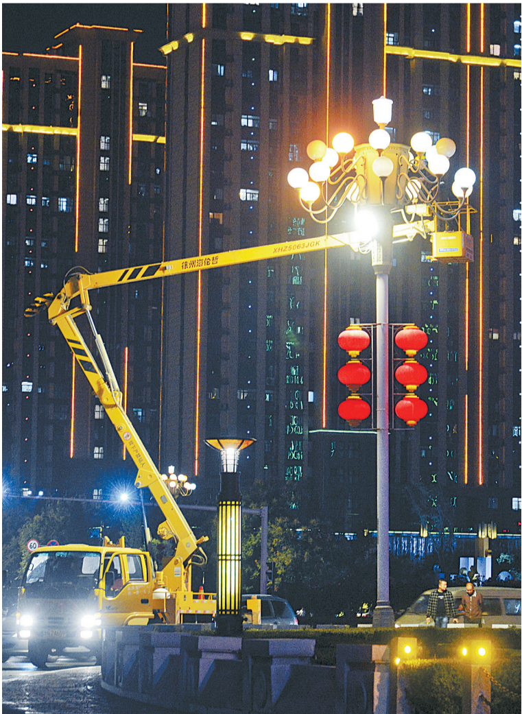
▲9月26日晚，市路灯管理处技术人员在神火大道检修路灯。国庆临近，市路灯管理处对市区主要道路的路灯进行维护、更换光源，以更高的亮灯率来迎接国庆佳节。 本报记者 崔坤 摄
