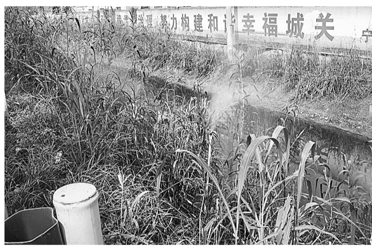
记者看到,这片人工斜坡湿地使用太阳能雾阵的方法,把污水喷淋到吸污草上,通过吸污草的蒸腾、吸附、渗透等
