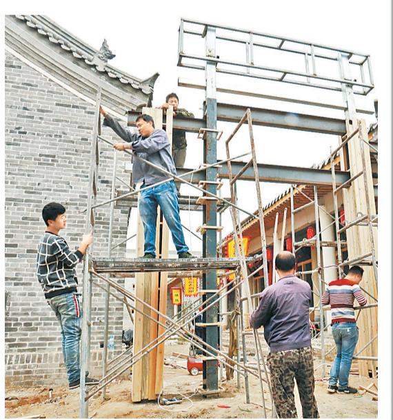
10月14日，商丘古城美食街（S3商业街）正在进行院门施工。为确保在第七届中国·商丘国际华商节期间如期开放，睢阳区加班加点推进古城美食街5个庭院的地下管网、地上绿化、夜景照明等工作。经过半个月的连续奋战，目前进入最后收尾阶段，100多家美食店铺也在积极准备开张迎客。
