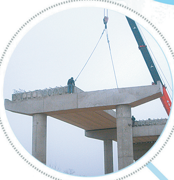
▲跨铁路立交桥施工。
