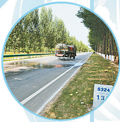
▶公路扬尘治理。
