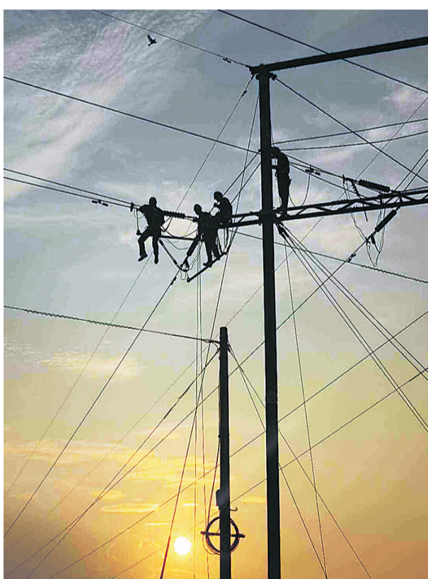
电网建设施工。
