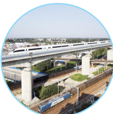
▲京九铁路与陇海铁路、郑徐高铁与正在建设中的商合杭高铁交会处。本报记者 崔坤 摄
