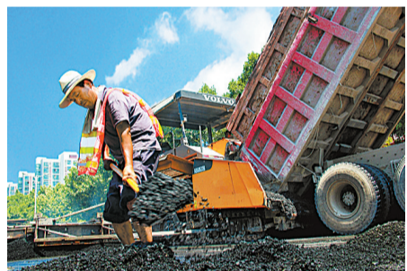
烈日下为加快城市道路建设的修路工人。本报记者 邵群峰 摄
