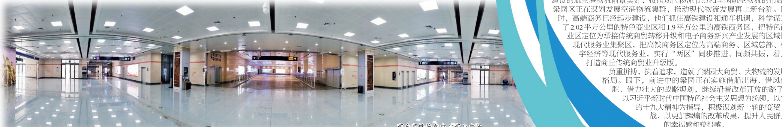
商丘高铁换乘中心商业广场
