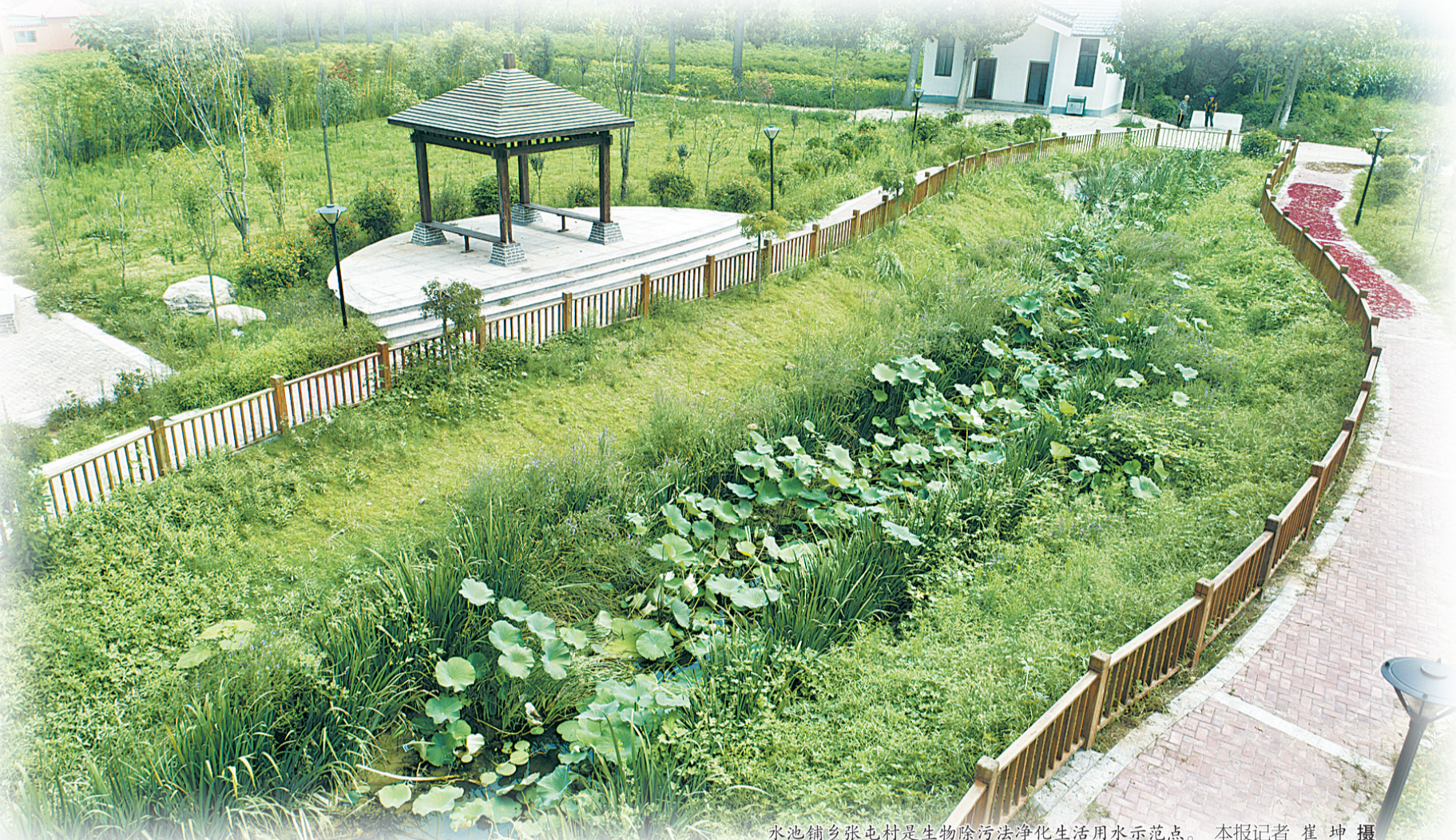
水池铺乡张屯村生物除污净化生活用水示范点。本报记者 崔坤 摄
