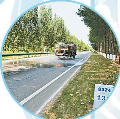
►公路扬尘治理。
