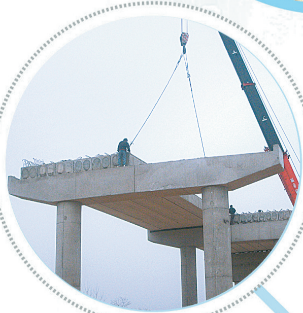
▲跨铁路立交桥施工。
