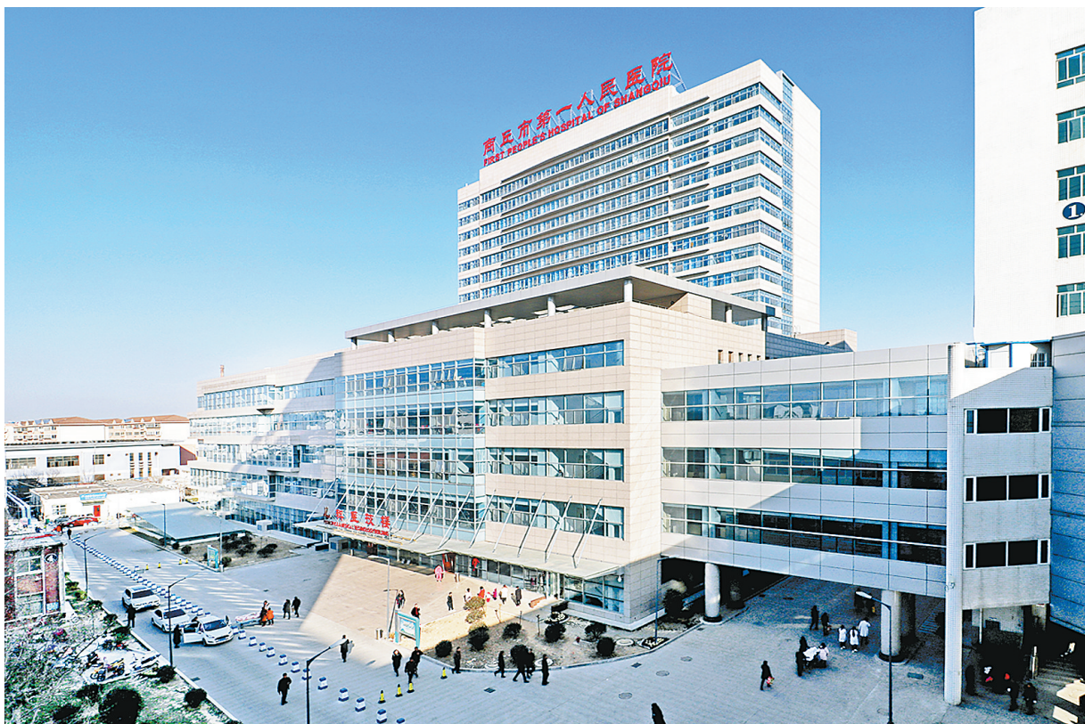
儿科医技楼全景图
