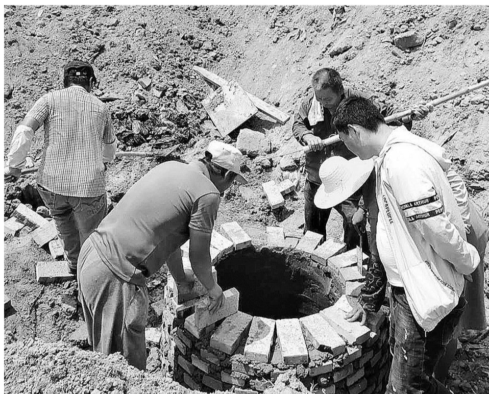
6月18日,睢阳区市政人员对市政道路积水点进行改造。为解决城区市政道路积水隐患,全力保障广大市民安全度过即将到来的汛期,近日,睢阳区市政建设局全面开启城区积水点改造工作。在汛期来临之前,计划投资310万元,对神火大道与张巡路交叉口东侧、君台路与珠江路交叉口、郑南路与金桥路交叉口、长江路与九州路交叉口、南京路与九州路交叉口南侧等8处位置的市政道路积水点进行改造。
