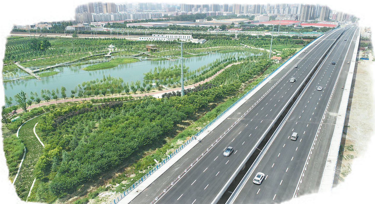
长江东路上跨京九铁路立交桥
