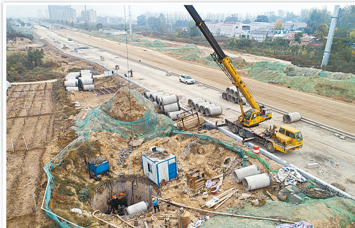
▲11月3日,施工人员在南京西路项目建设工地吊装地下配套管网。近年来,我市积极实施中心城区主次干道拓宽工程、道路改扩建工程和街头路打通工程,道路交通环境不断提升,群众出行更加方便。 本报记者 崔坤 摄
