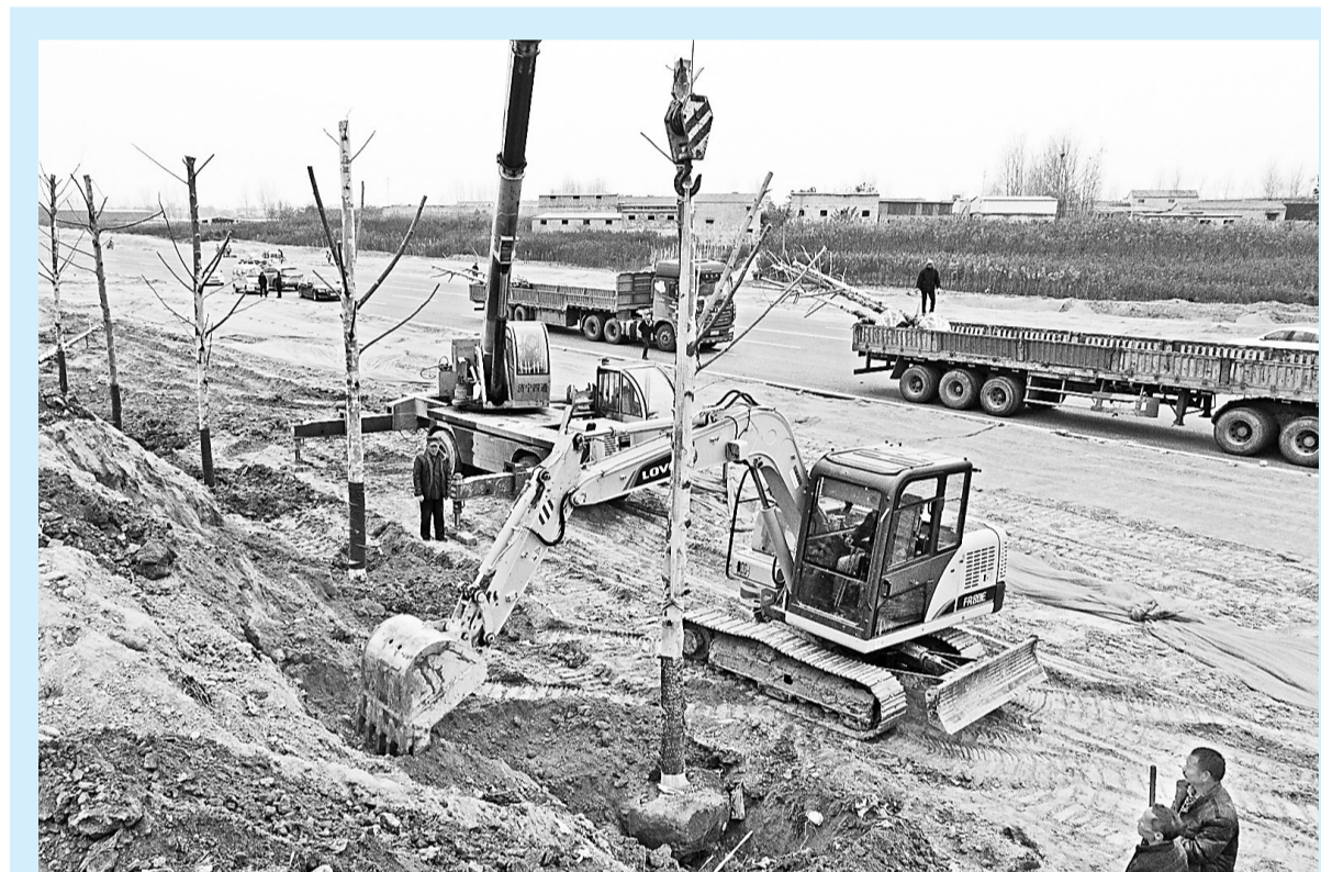
12月7日,施工人员在市商都大道南延段栽种景观树木。目前,商都大道南延段(华商大道至商丘东站)道路主体工程完工通车,道路两侧配套设施建设正加紧推进中。 本报记者 崔 坤 摄
