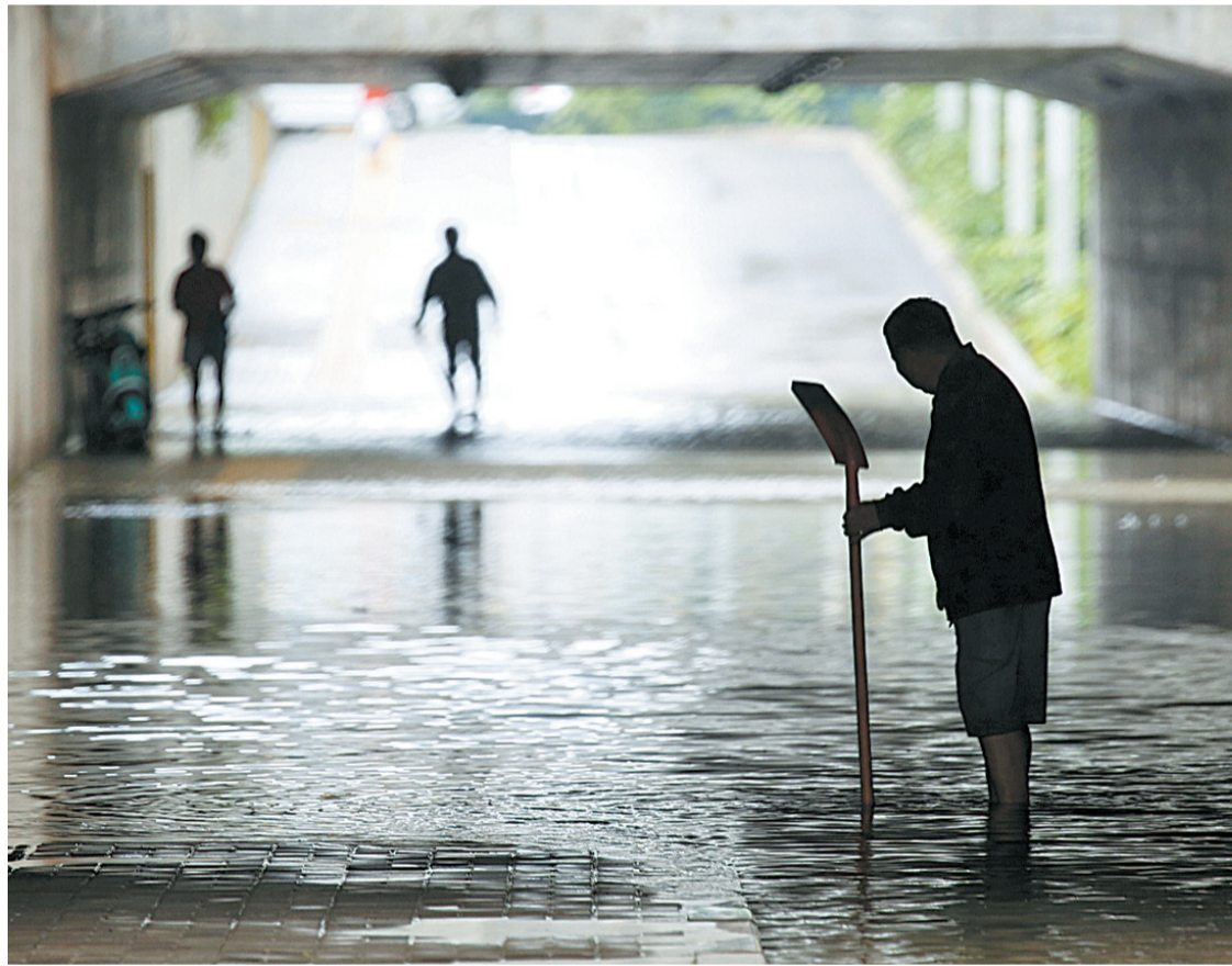
7月29日，大雨过后，工作人员在凯旋路立交桥人行通道内疏通下水道，及时排出积水，方便行人通过。 本报记者 傅青 摄
