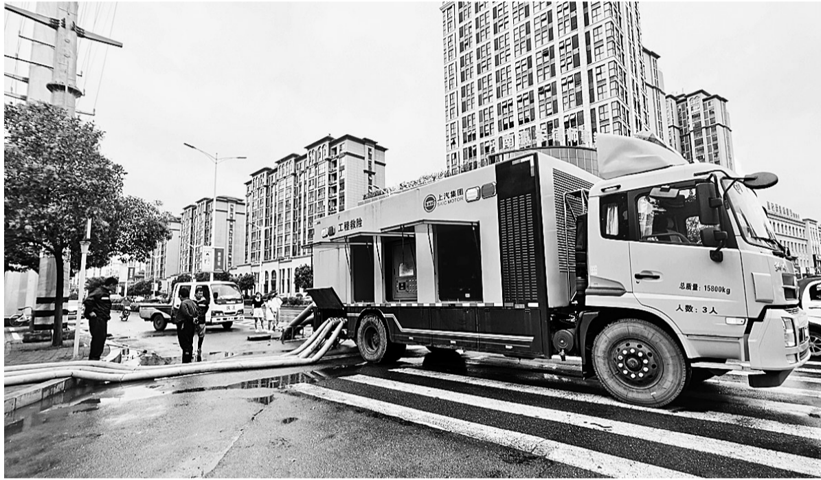
7月29日,市区珠江路与睢阳大道交叉口西南角,一辆防汛排涝移动泵车正在排水作业。据了解,暴雨过后,该路段严重积水,示范区防汛指挥中心迅速调来大功率防汛排涝移动泵车进行排涝作业,方便群众出行。 本报记者 邢栋摄
