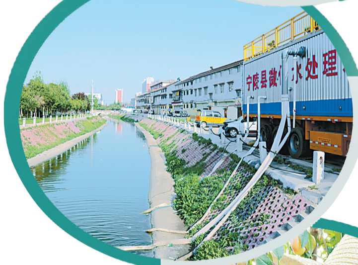
▲污水处理换水清 本报记者 高会鹏 摄
