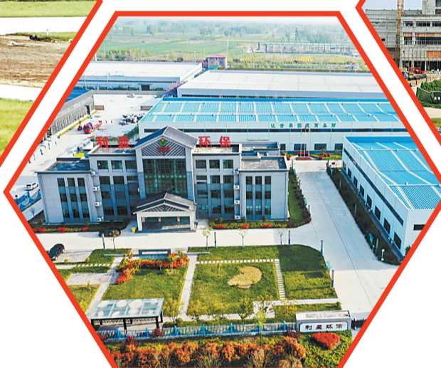
▲民权县垃圾焚烧发电项目预计国庆节后投产发电。本报记者 闫鹏亮 摄
