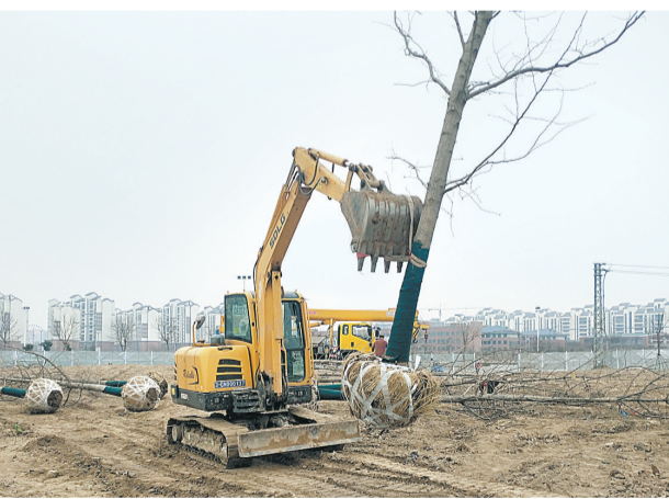
2月16日,随着第一批银杏树的进场,睢阳区紫荆路生态廊道(南段)建设正式拉开序幕。睢阳区市政建设局抢抓春季绿化植树有利时机,扎实推进生态廊道建设,持续美化城市市容环境。 本报融媒体记者 邵群峰 通讯员 温庆玲 摄
