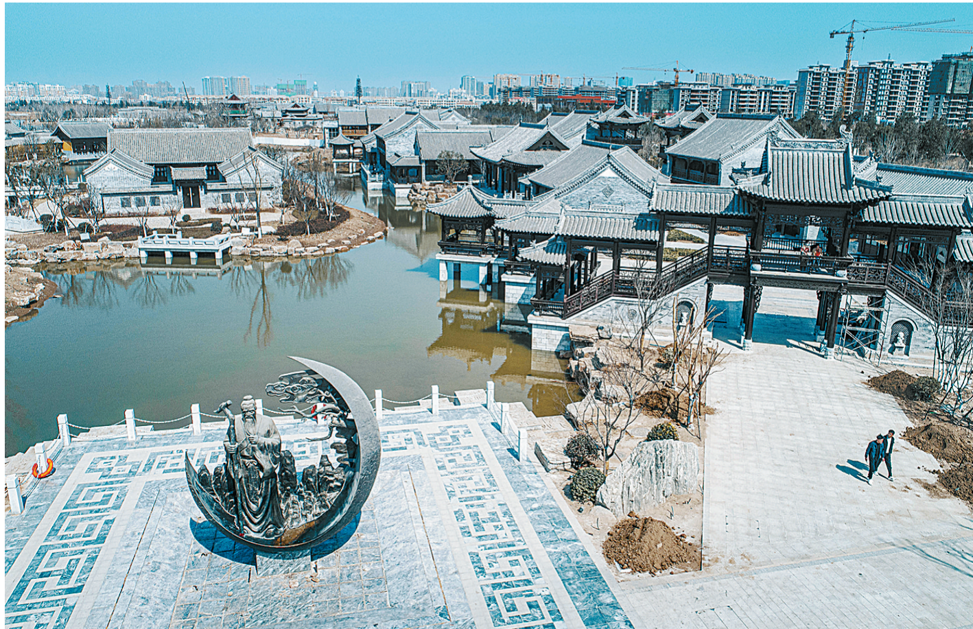
3月10日,位于商丘古城城湖东侧的月老文化公园项目一角。月老公园以月老文化为主题,集休闲娱乐、婚庆文化传承为一体。目前,一期工程已完工,二期工程正在建设中。本报融媒体记者 崔坤摄
